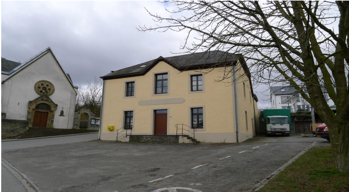
Figure 1 : Ancien bâtiment servant comme caisse rurale et comme local associatif dans la localité de Troine
