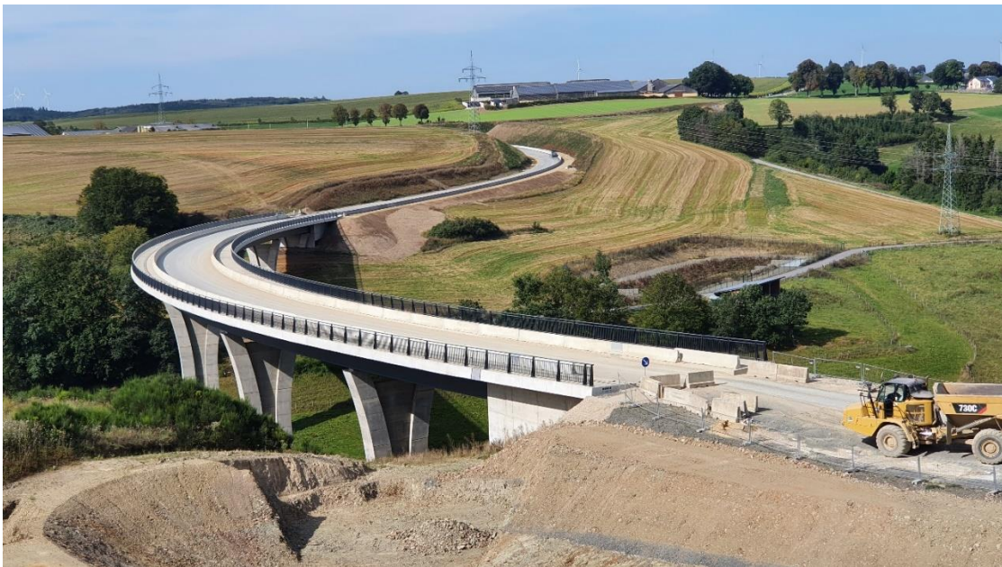
Figure 2 : Viaduc Irbich réalisé par les P.&Ch. dans le cadre du remembrement de Clervaux
