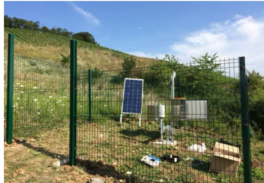
Die Errichtung der Meteostation in Remerschen (Foto: Robert Mannes)
