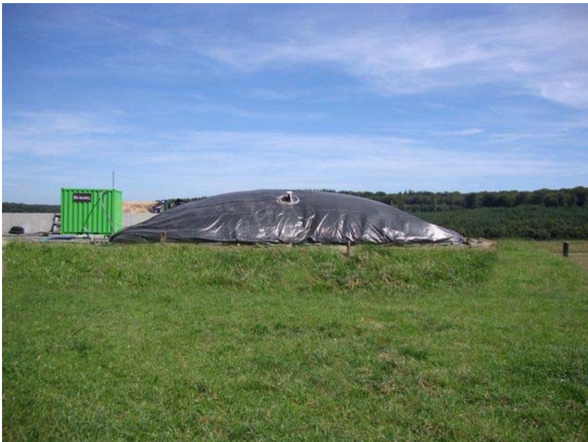
Photo 2: In dem Standardcontainer (links) ist fast die gesamte Technik der Biogasanlage untergebracht, lediglich ein Tauchmischer befindet sich im Fermenter.
