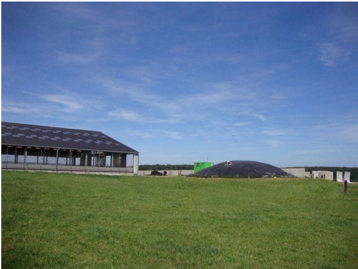
Photo 1: Die frische Gülle von \pm 80 Milchkühen reicht aus um die 10kW-Biogasanlage zu betreiben.
