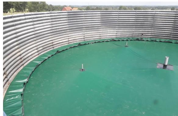
Güllelagerabdeckung mit Schwimmfolie (Quelle: Genap B.V.)
