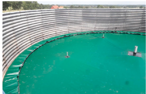
Güllelagerabdeckung mit Schwimmfolie (Quelle: Genap B.V.)
