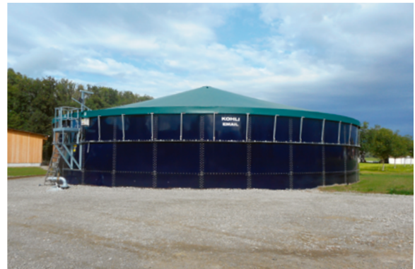
Güllelagerabdeckung mit Zeltdach (Quelle: H.U. Kohli AG)
