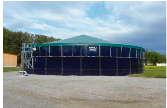
Güllelagerabdeckung mit Zeltdach (Quelle: H.U. Kohli AG)
