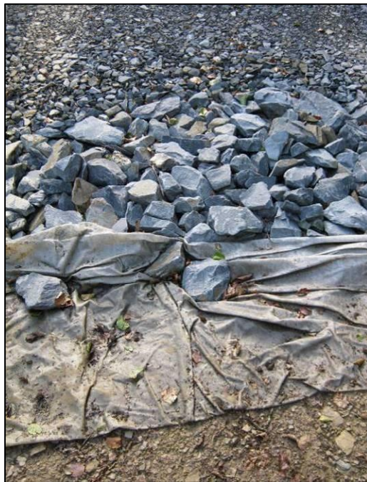
FIGURE 10 : ILLUSTRATION DES DIFFERENTS DIAMETRES DE MATERIAUX UTILISES POUR LA CREATION DES CHEMINS
