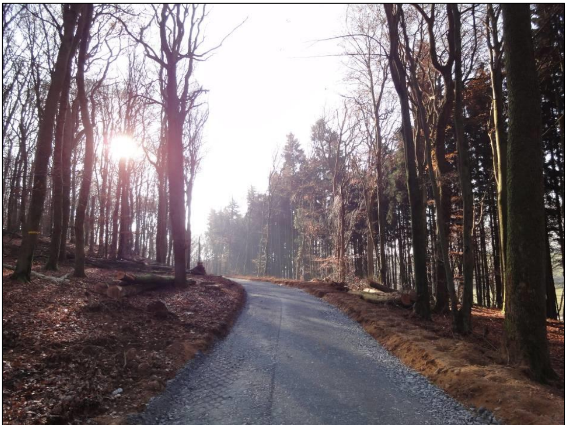
FIGURE 16 : CHEMIN A LA FIN DES TRAVAUX
