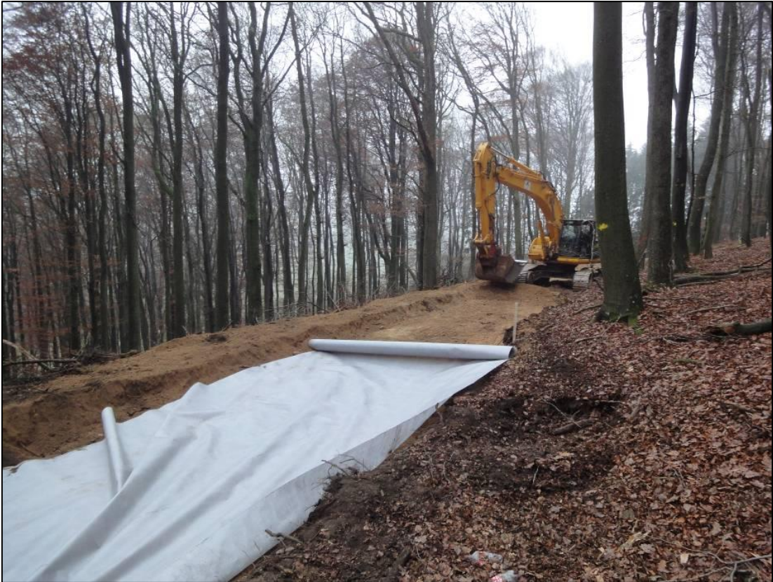
FIGURE 13 : MISE EN PLACE DU GEOTEXTILE
