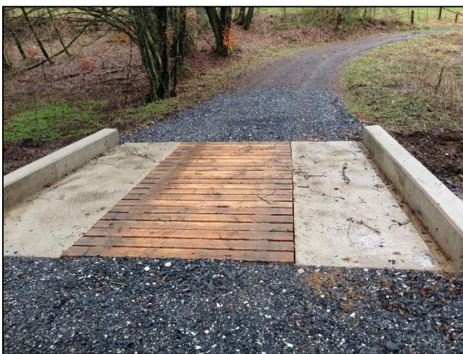
FIGURE 18 : PONT AVEC TABLIER EN BOIS ET STRUCTURE EN BETON
