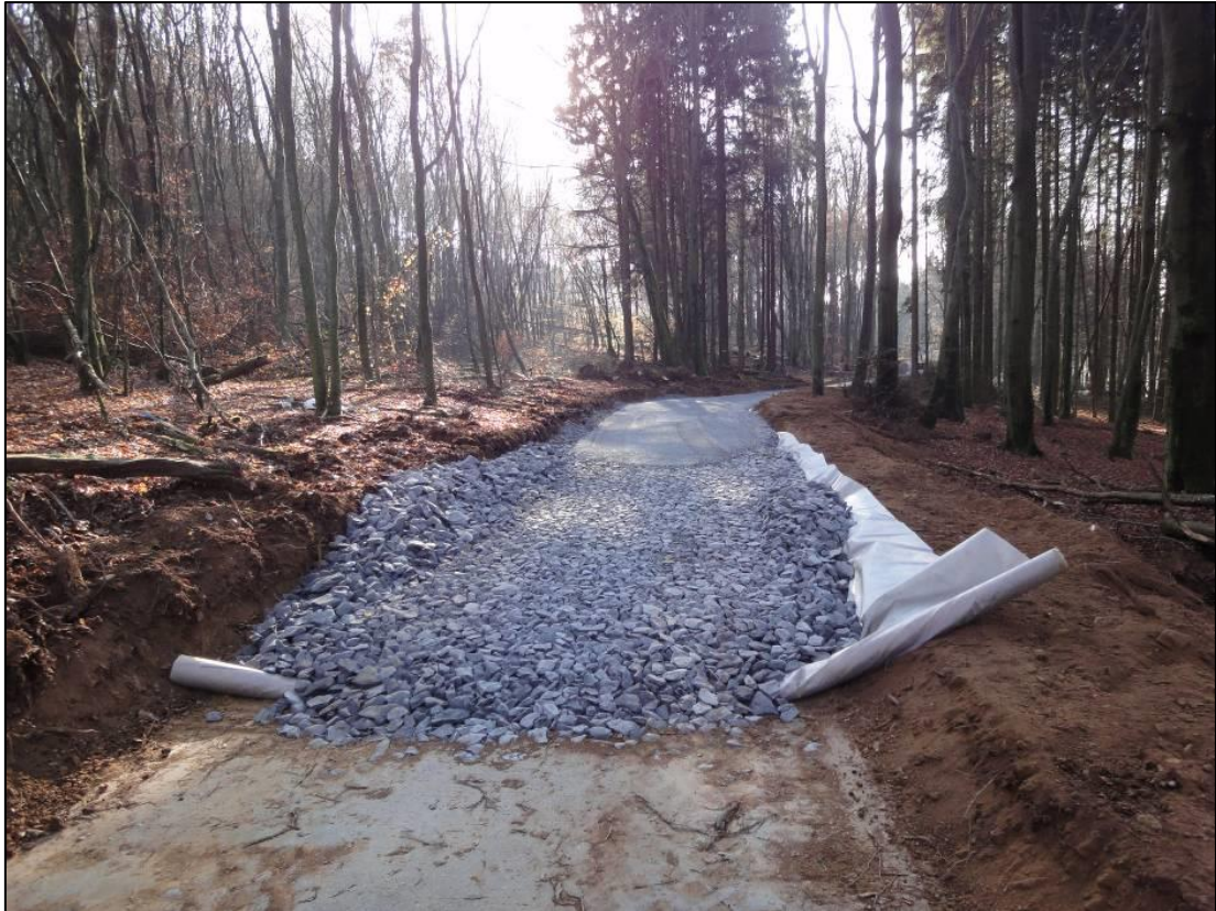
FIGURE 15 : MISE EN PLACE DE LA COUCHE SUPERIEURE D'EMPIERREMENT
