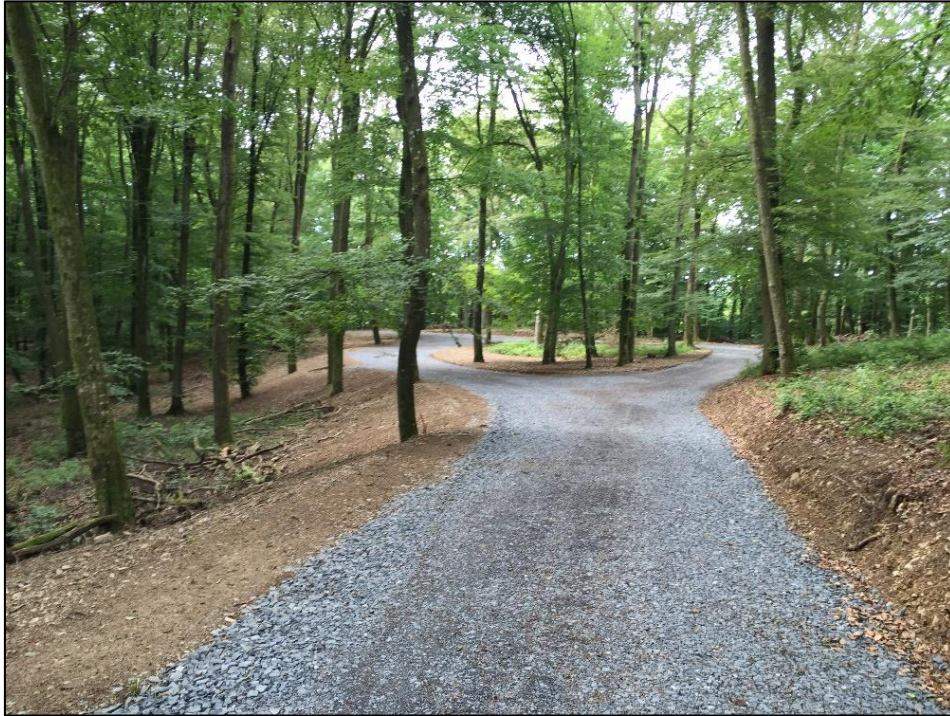
FIGURE 21 : AMENAGEMENT EN ROND-POINT D'UNE PLACE DE VIRAGE
