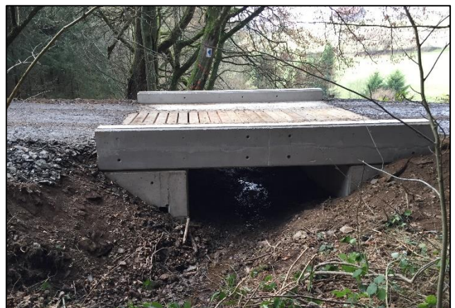
FIGURE 18 : PONT AVEC TABLIER EN BOIS ET STRUCTURE EN BETON
