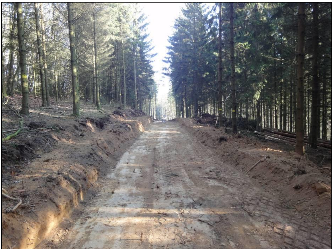
FIGURE 12 : CREUSEMENT DE L'EMPREISE DU CHEMIN
