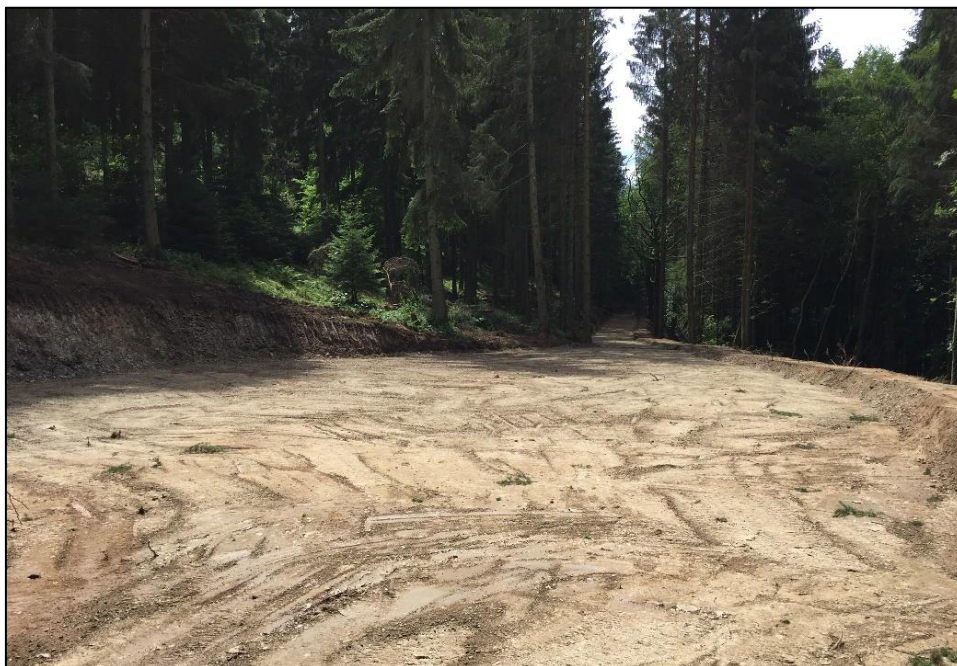
FIGURE 20 : AMENAGEMENT CLASSIQUE D'UNE PLACE DE VIRAGE DE 12M DE RAYON
