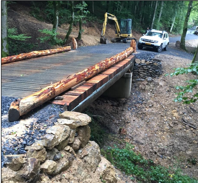
FIGURE 19 : PONT A GRANDE PORTEE (JUSQU'A 12M)
