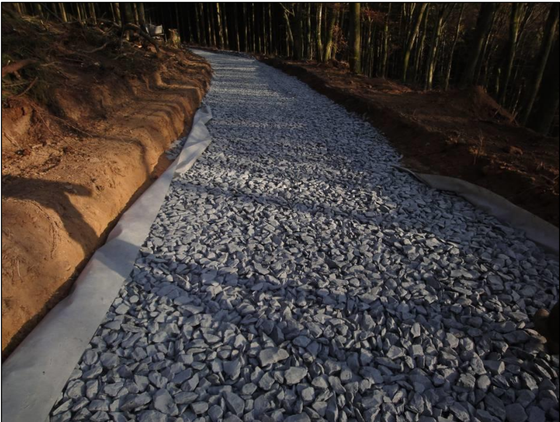
FIGURE 14 : MISE EN PLACE DE LA COUCHE INFERIEURE D'EMPIERREMENT
